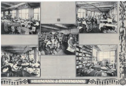
Abbildungen der Arbeits- und Lagerräume aus dem Warenkatalog des Unternehmens Hermann J. Kaufmann vor 1925
